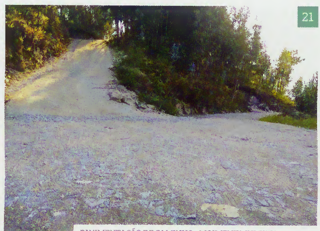
PAVIMENTAÇÃO DE CAMINHO - MOIMENTA DE CIMA
