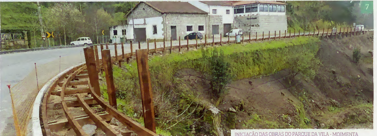
iniciação das obras do parque da vila - moimenta
