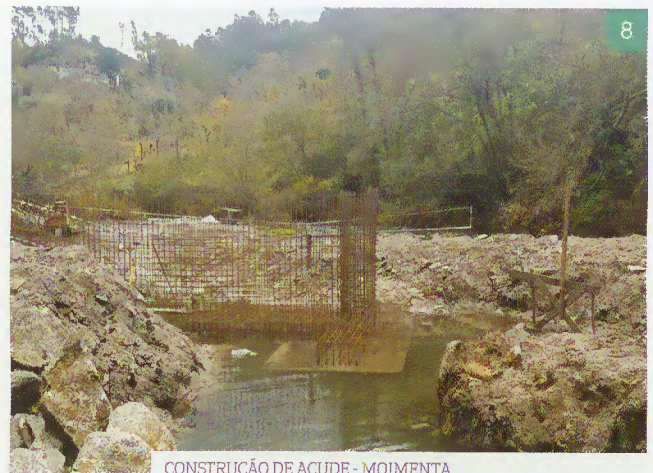
CONSTRUÇÃO DE AÇUDE - MOIMENTA
