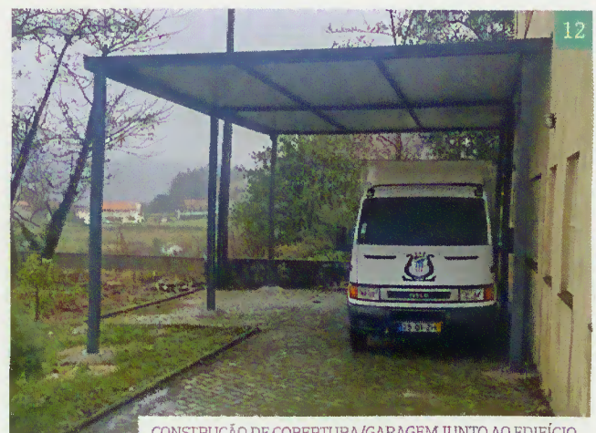
CONSTRUÇÃO DE COBERTURA/GARAGEM JUNTO AO EDIFÍCIO DA SEDE DA JUNTA - CARVALHEIRA
