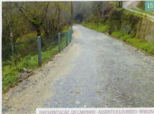
PAVIMENTAÇÃO DE CAMINHO - ASSENTO E LOUREDO - RIBEIRA
