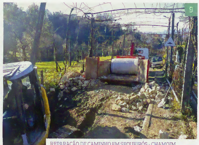
REPARAÇÃO DE CAMINHO EM SEQUEIRÓS - CHAMOIM
