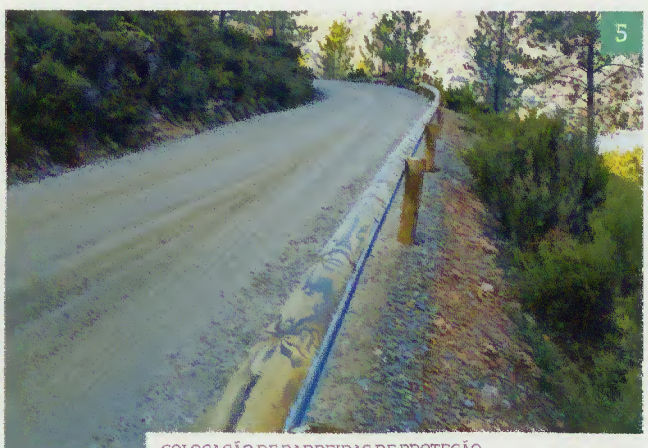
COLOCAÇÃO DE BARREIRAS DE PROTEÇÃO
