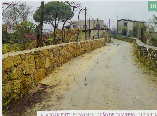
ALARGAMENTO E PAVIMENTAÇÃO DE CAMINHO - LUGAR DA IGREJA - SÓUTO
