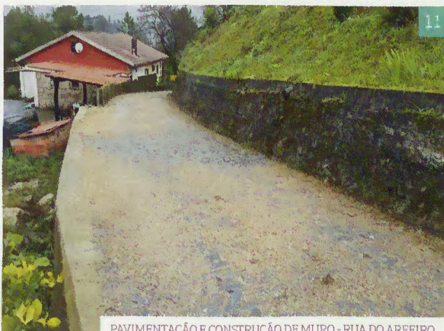
PAVIMENTAÇÃO E CONSTRUÇÃO DE MURO - RUA DO AREIRO DE BAIXO - CARVALHEIRA
