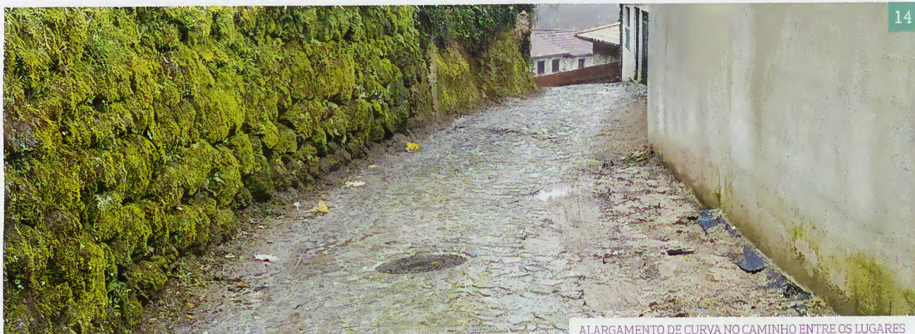
ALARGAMENTO DE CURVA NO CAMINHO ENTRE OS LUGARES DE ÁGUA LEVADA E MOURE - BALANÇA
