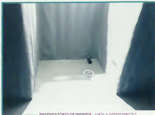
RESERVATÓRIO DE INFESTA - APÓS A INTERVENÇÃO
