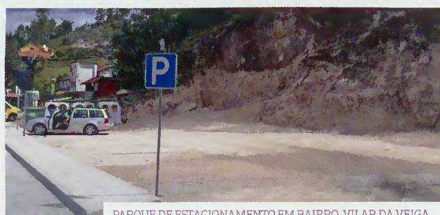
PARQUE DE ESTACIONAMENTO EM BAIRRO, VILAR DA VEIGA
