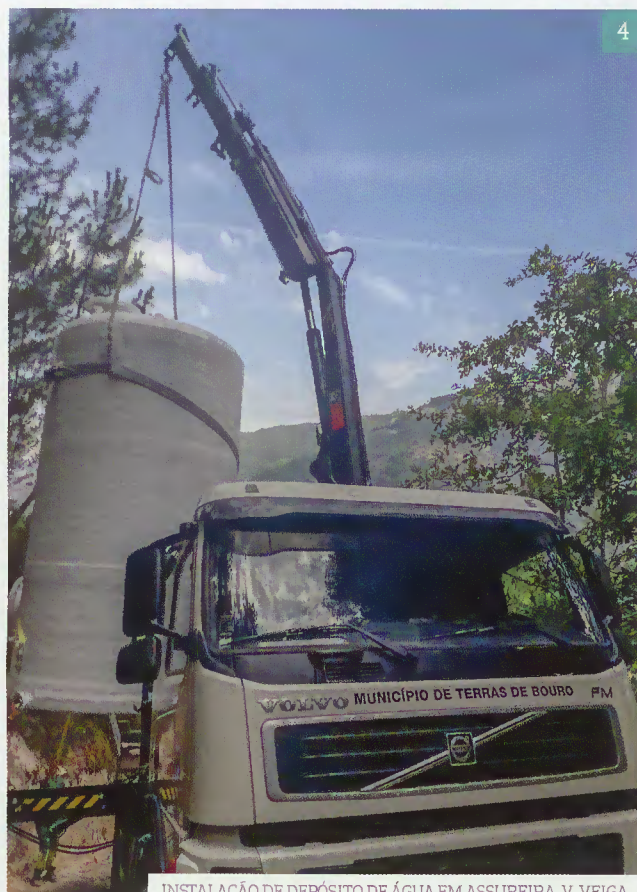
INSTALAÇÃO DE DEPÓSITO DE ÁGUA EM ASSUREIRA, V. VEIGA
