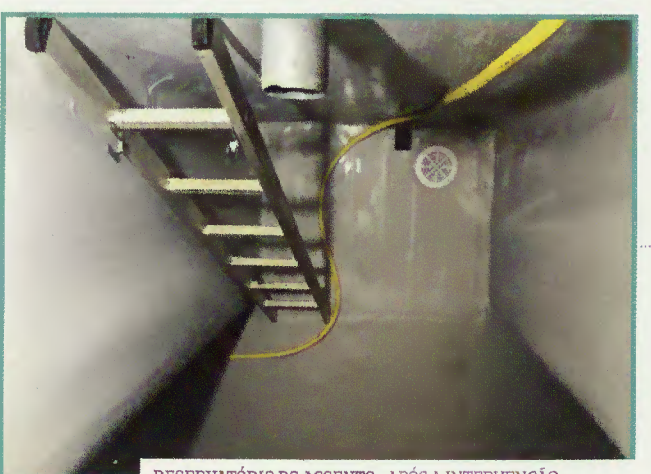
RESERVATÓRIO DO ASSENTO - APÓS A INTERVENÇÃO
