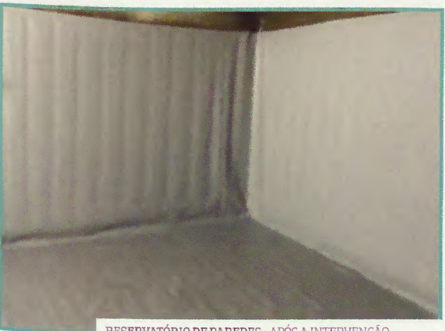
RESERVATÓRIO DE PAREDES - APÓS A INTERVENÇÃO
