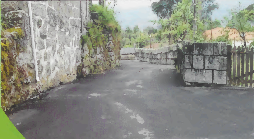
Pavimentação da rua do Casal, Chorense
