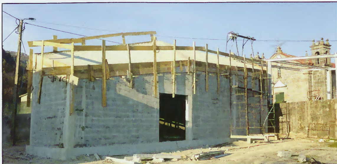
Obras da casa mortuária de Cibões
