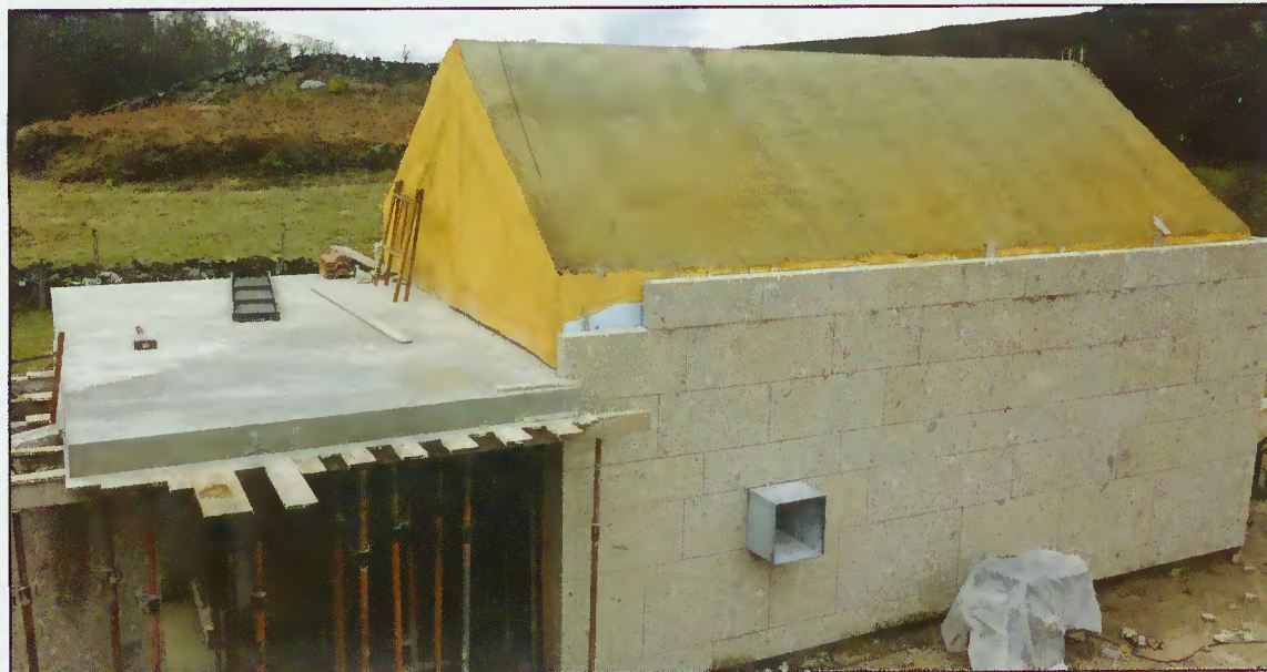
Obras da casa mortuária de S.ta Isabel do Monte
