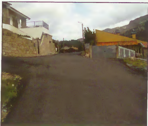
Forte aposta na melhorias das vias e estradas municipais
