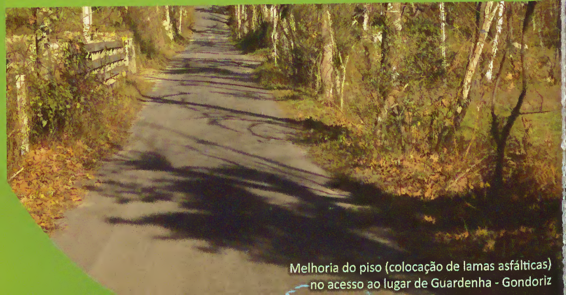
Melhoria do piso (colocação de lamas asfálticas) na estrada municipal de Gondoriz para Cibões
