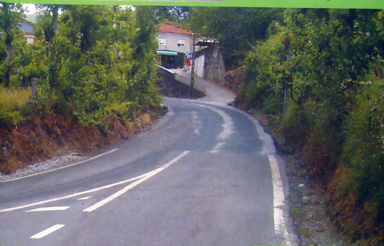
Asfaltamento na Freguesia de Souto
