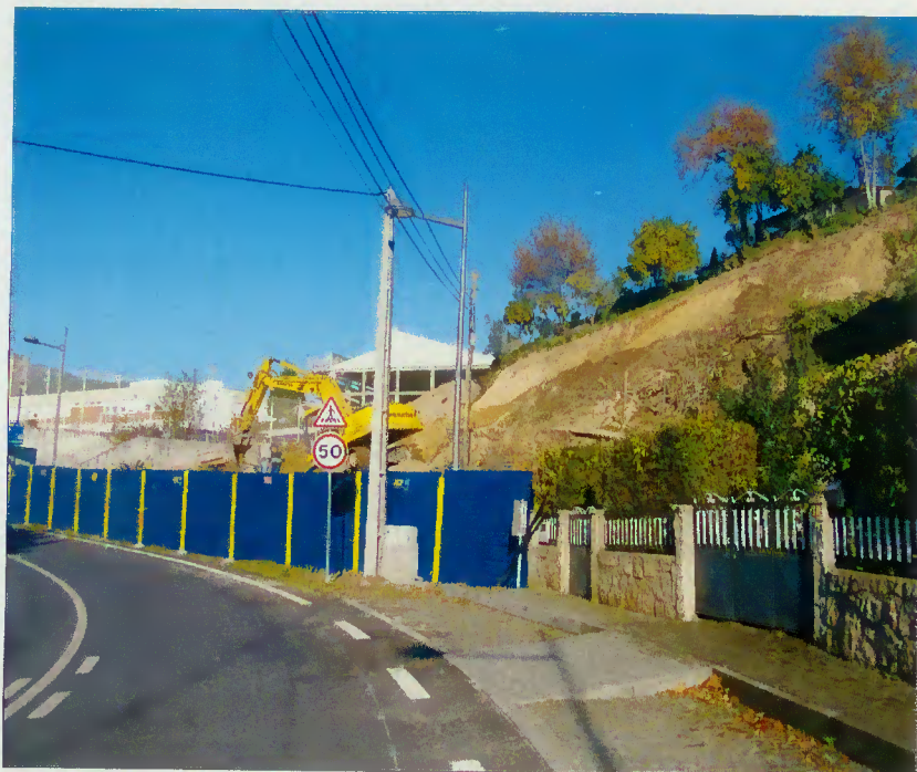
Ínicio das obras de construção do pavilhão gimnodesportivo
