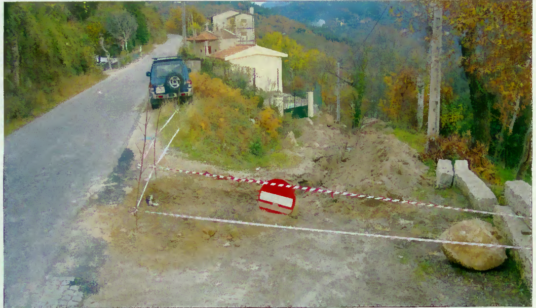
Conclusão da rede de abastecimento
