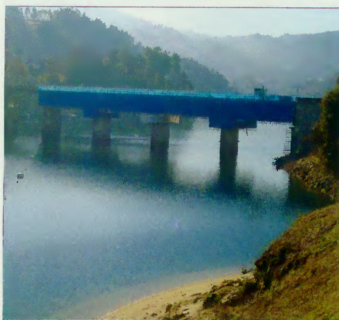
Visão parcial da intervenção na ponte entre Rio Caldo e Vieira do Minho
