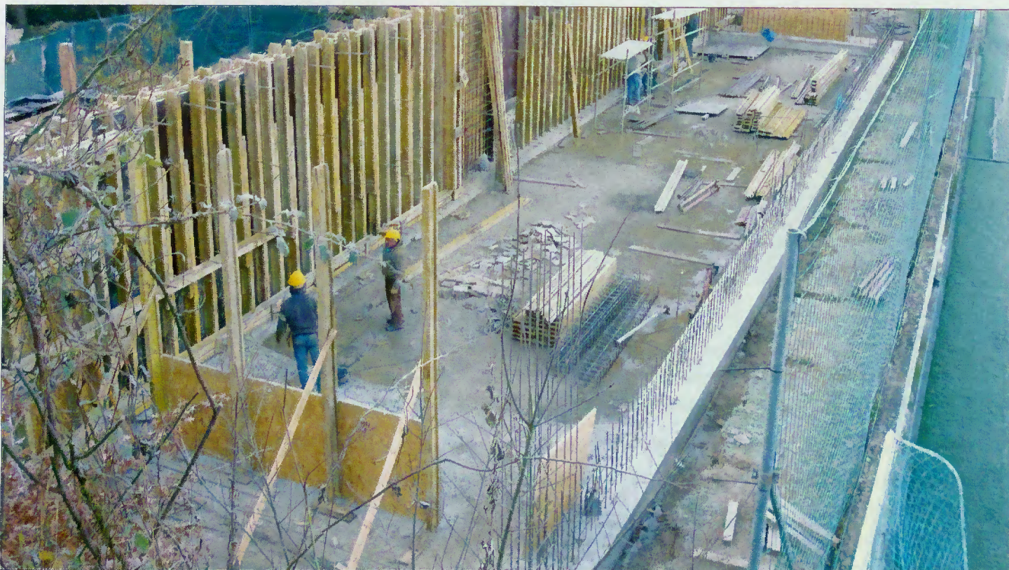
Obras em curso
