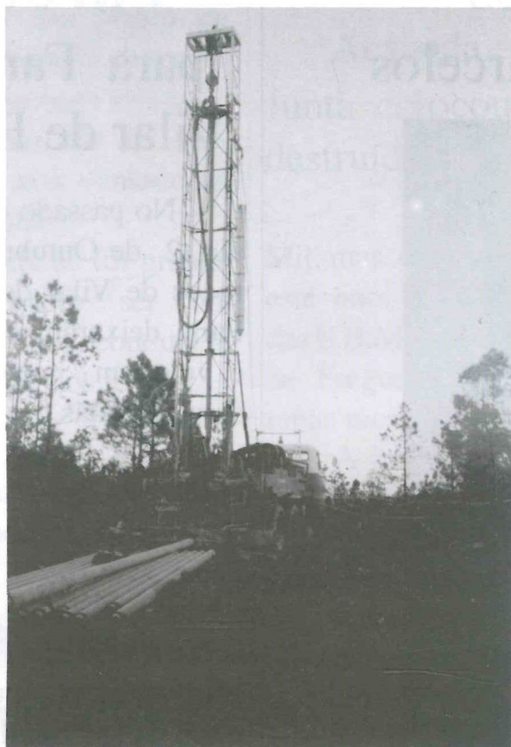
As obras para a canalização
