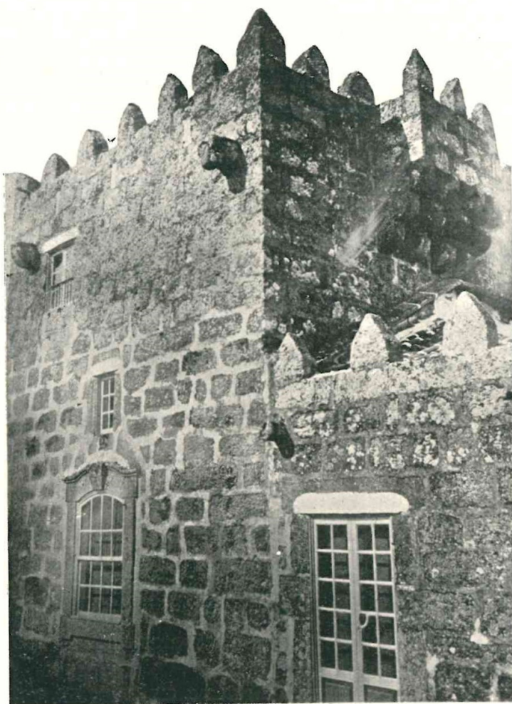
TORRE DE CURUTÉLO
