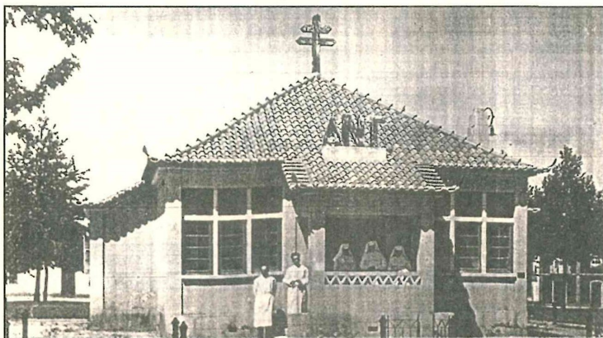
Figura 5 - Aspeto do edifício da Assistência Nacional aos Tuberculosos, em 1937. nota 5
