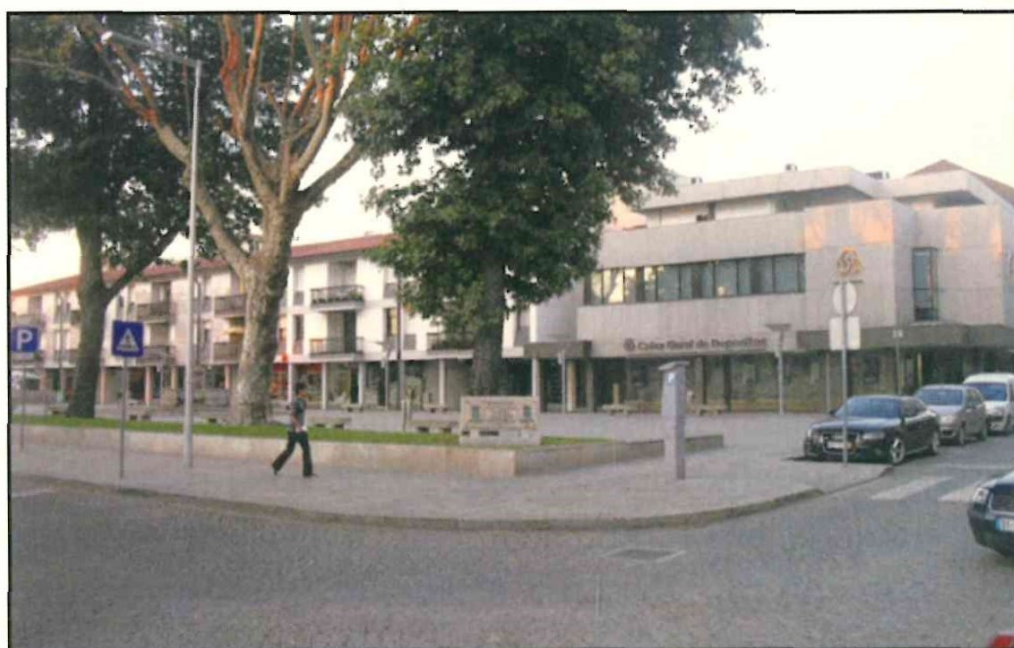
Figura 11 - Aspeto atual da Praça de Pontevedra.
