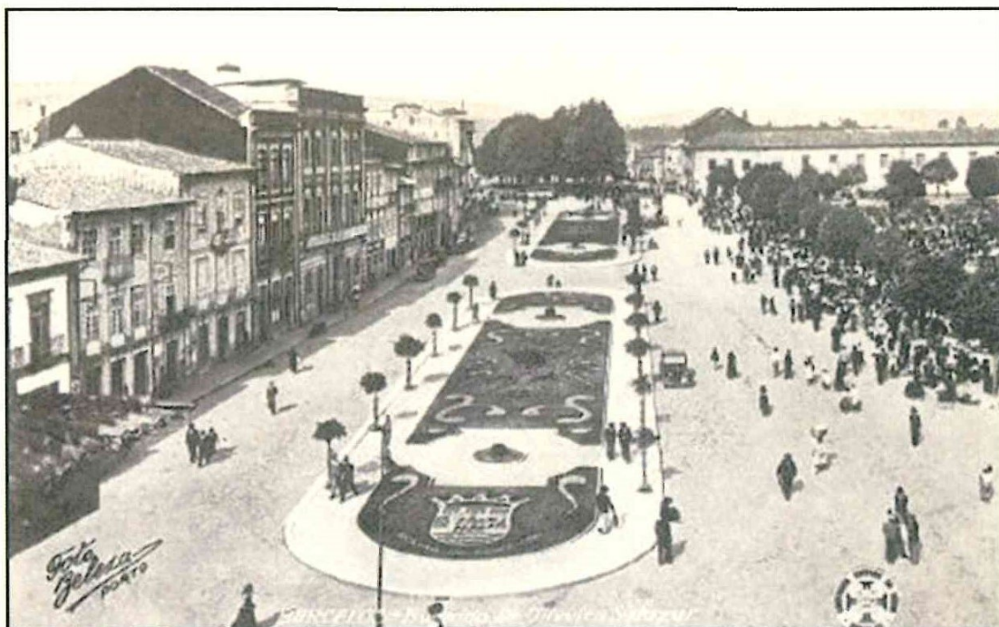
Figura 40 - A Avenida da Liberdade já com um separador central, foto feita entre 1940 e 1947. nota 11
