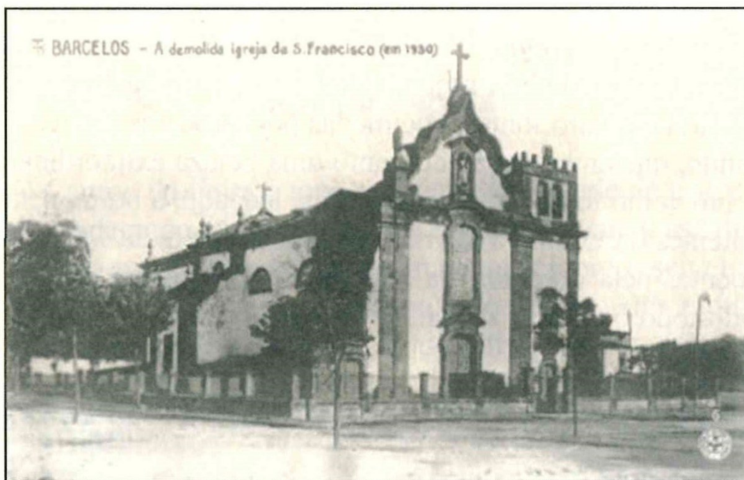
Figura 38 - Igreja dos Terceiros, já com uma das torres em baixo, em 1930. nota 11
