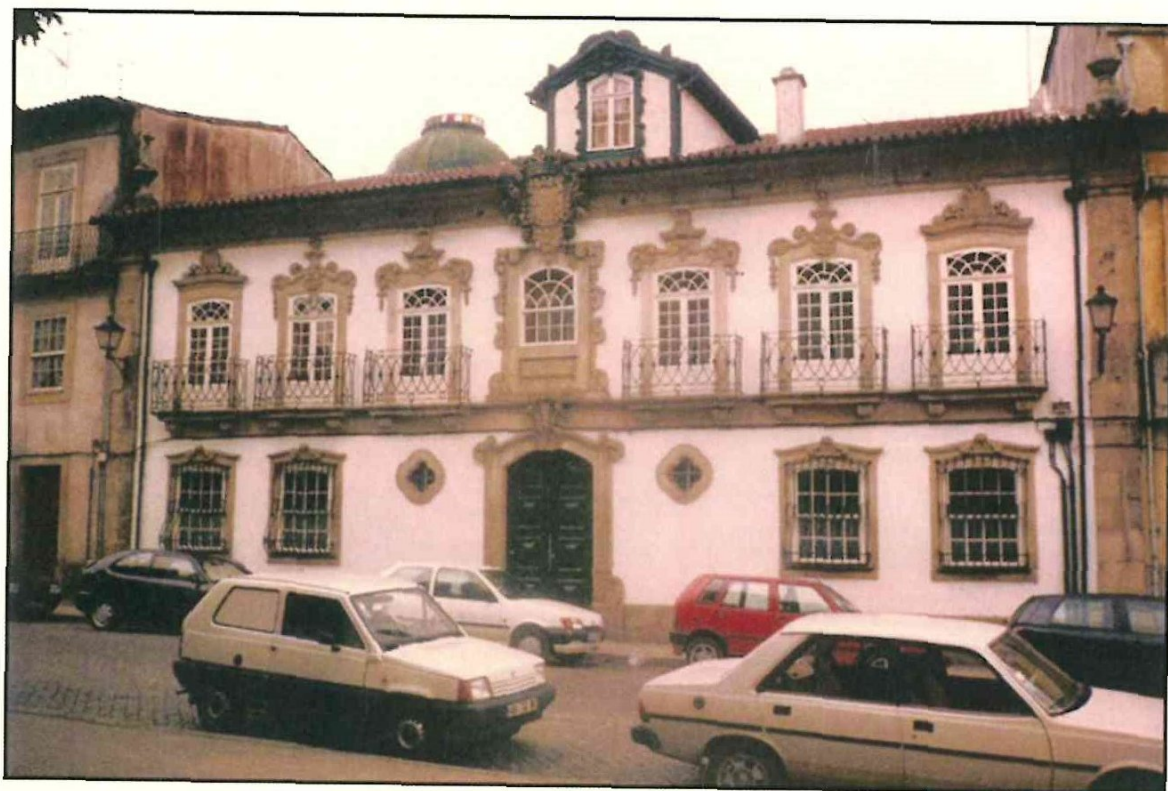
Figura 23 - Aspeto da casa Bessa e Menezes (1997).
