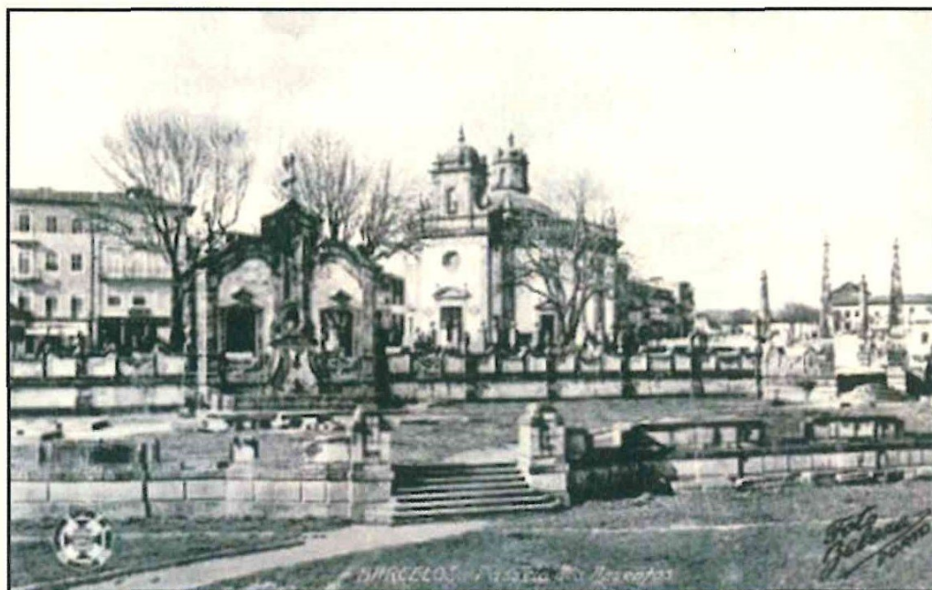
Figura 20 - As obras no Jardim das Barrocas (1935-1940?). nota 11
