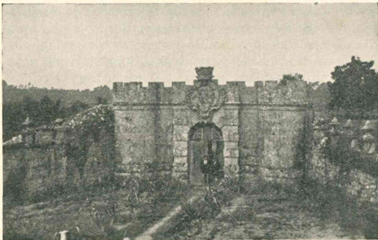
Portão da Casa de Pedregais
