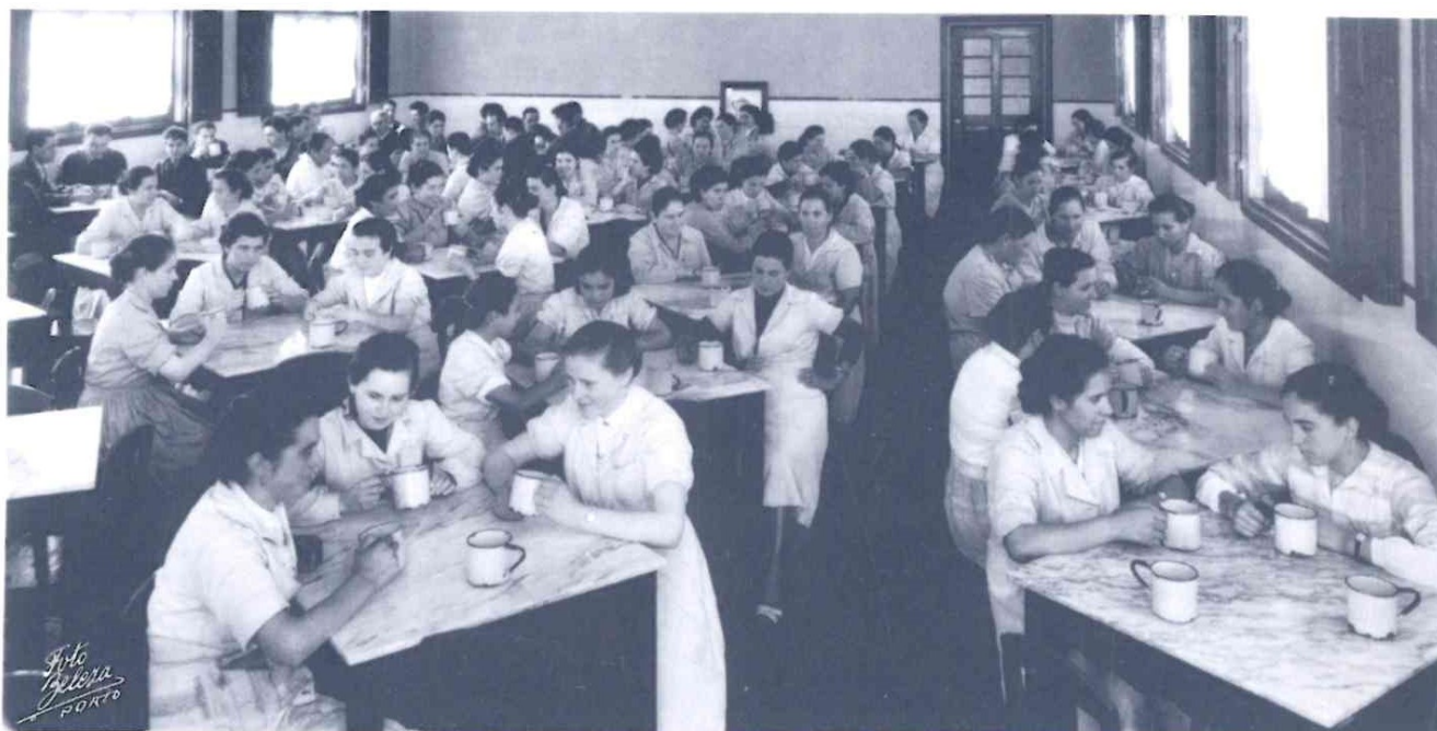
Fábrica Barcelense. um aspeto do refeitório, 1945
