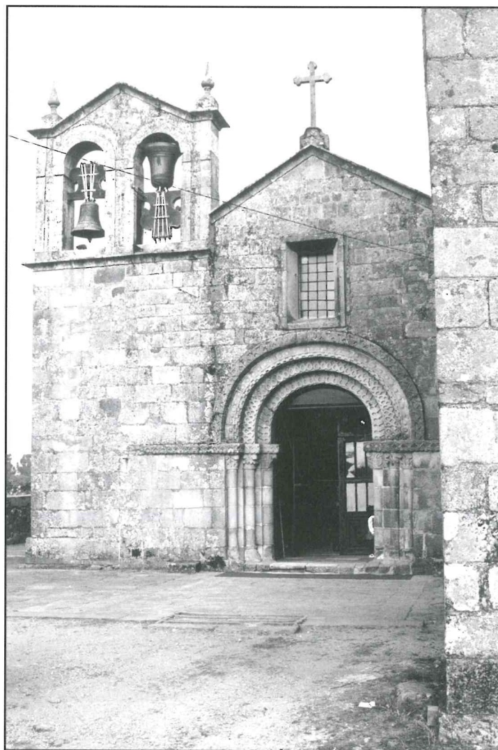
Igreja de Manhente
