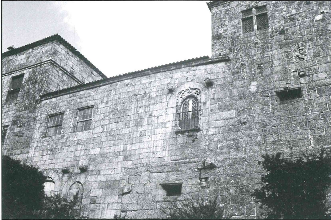
Solar dos Pinheiros, Barcelos
