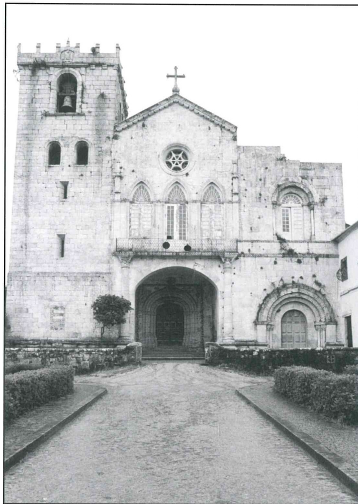
Igreja do Convento de Vilar de Frades, Areias de Vilar
