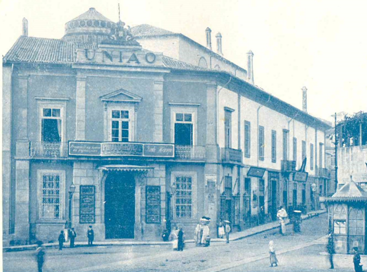
A FRONTARIA DO EDIFICIO
