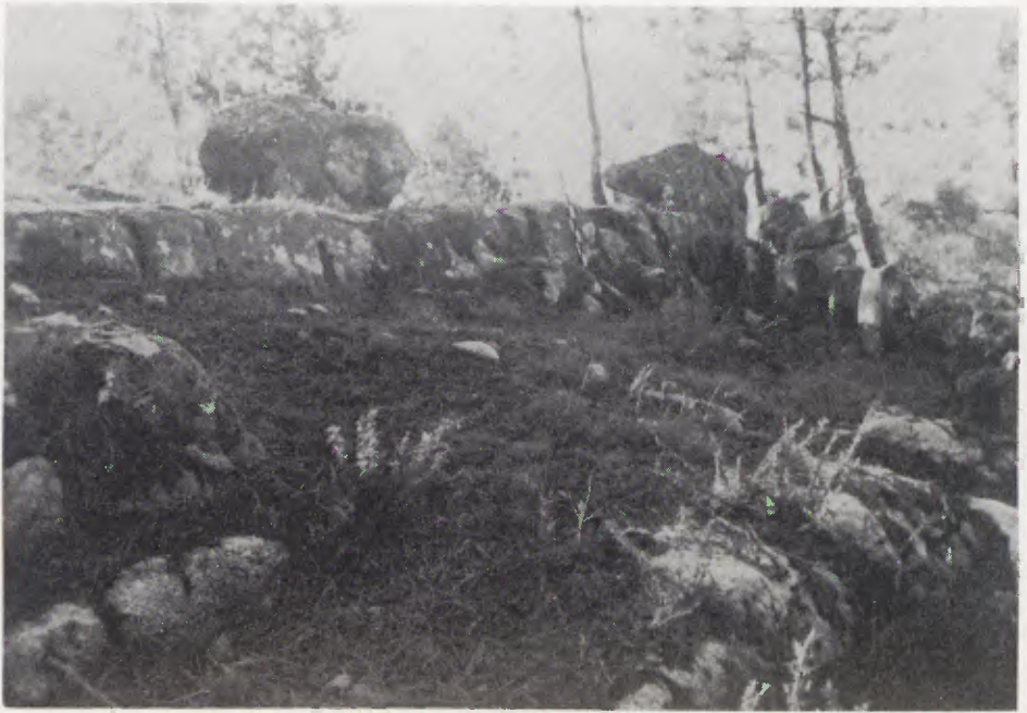
Rocha natural cortada e preparada para alicerce da muralha (Fig. 7)
