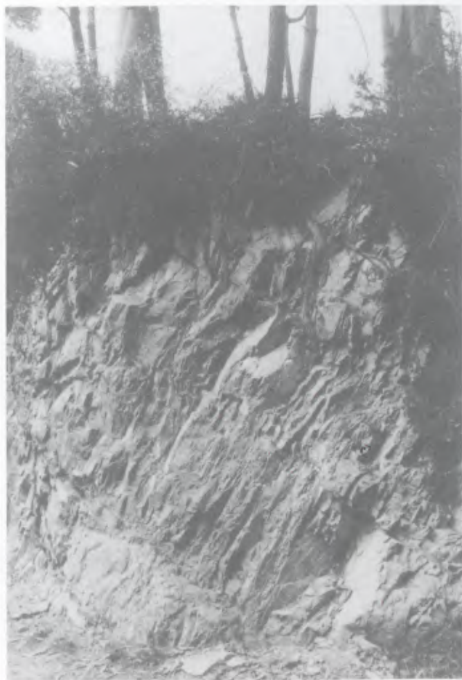
Fig. 17 — Quartzitos da Formação de Barca do Lago. A fracturação intensa deve-se à presença de um acidente N-S — falha da Reguenga.
