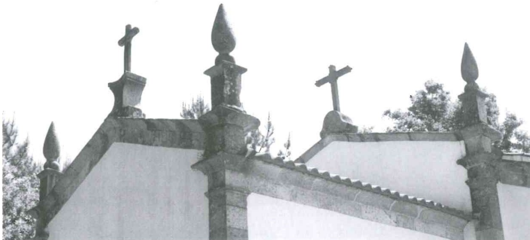
Fig. 5 A – Cruz e coruchéu da cabeceira da Capela do Socorro
