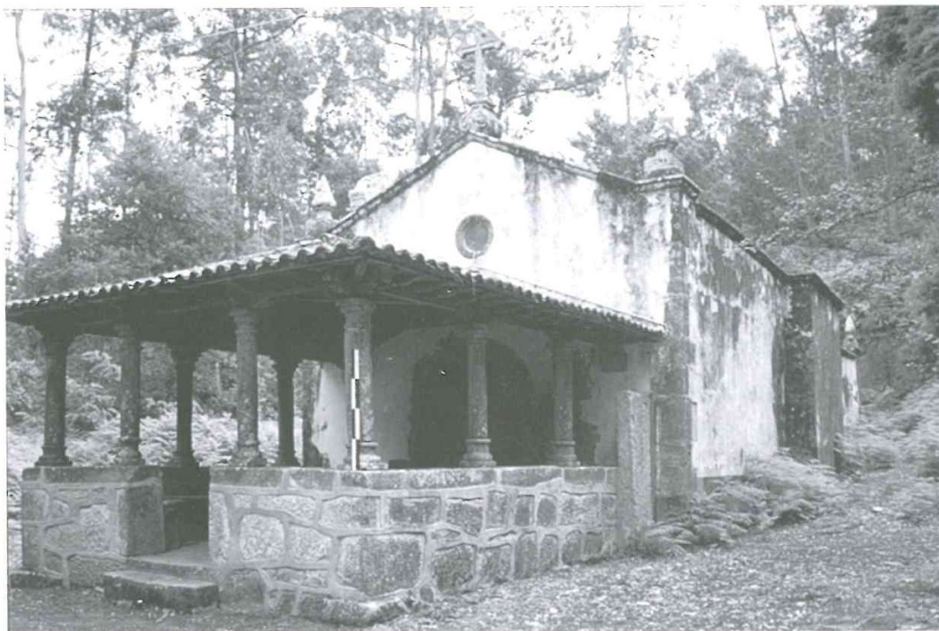
Fig. 14 – Capela da Casa de Belinho
