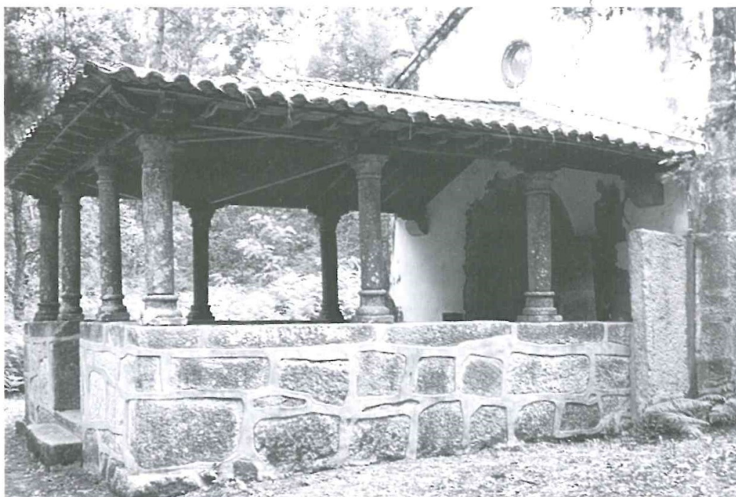
Fig. 6 – Alpendre da Capela da Casa de Belinho
