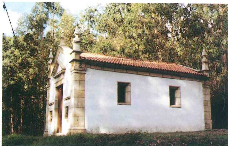
Capela de S. João (Fragoso)
