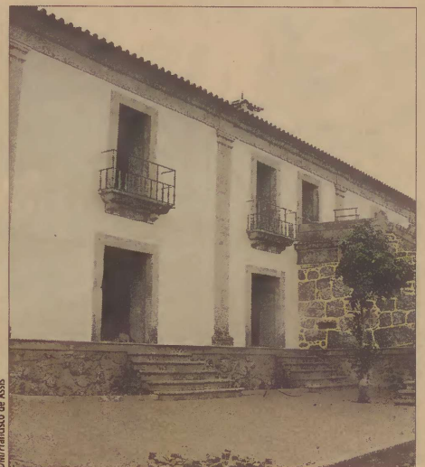
Escadório antigo e parte da casa em reconstrução
