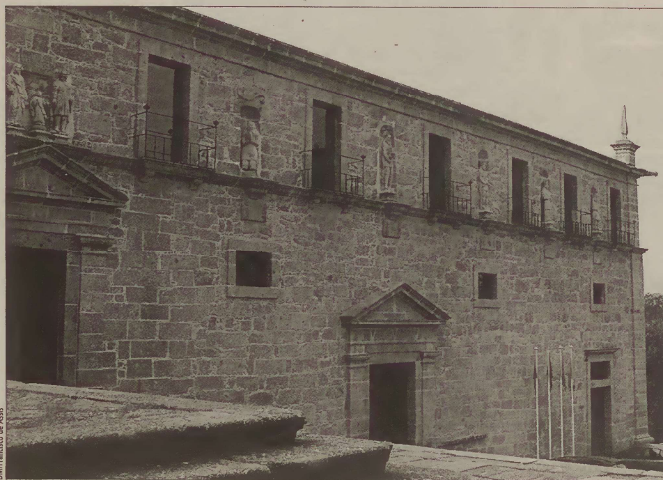
Fachada principal da Pousada de S. Maria de Bouro
