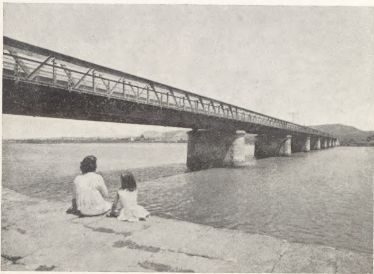
Ponte metálica de Fão
