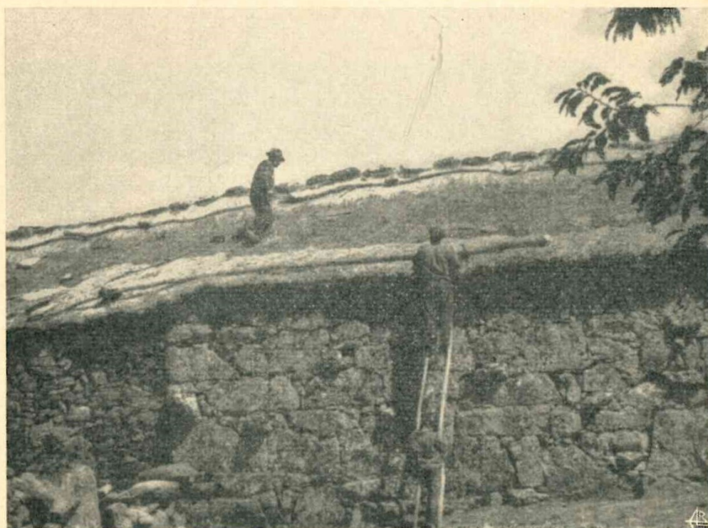
Fig. 28 — Na cobertura de colmo desta casa as partes mais claras são de colmo novo, entremeado e sobreposto ao velho escurecido pelas invernadas.
