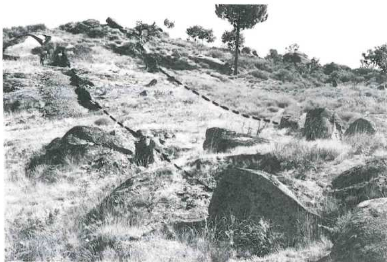
Fig. 19 — Aspecto da porção da muralha IV (fig. 2-n) totalmente destruída
