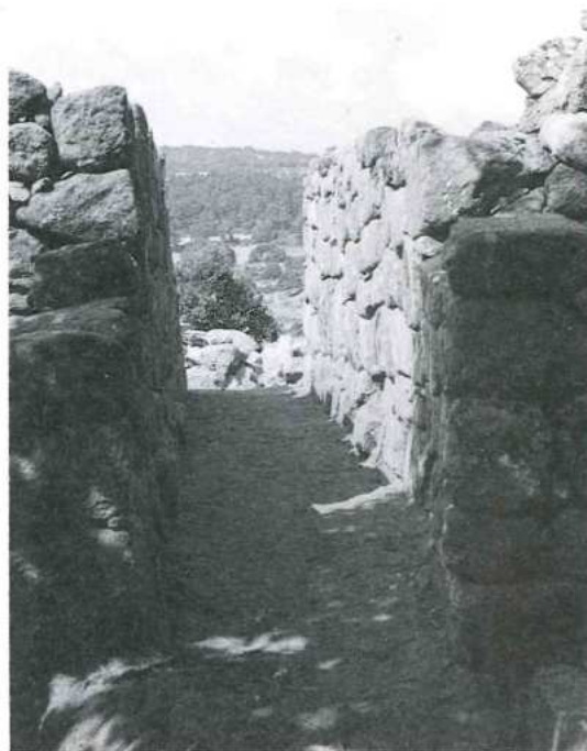
Fig. 15 — Aspecto da porta a no final dos trabalhos de 1988. A fotografia foi tirada do lado interno da muralha (fig. 3). Nos limites desta porta, apenas as fiadas basais de pedras não foram por nós repostas
