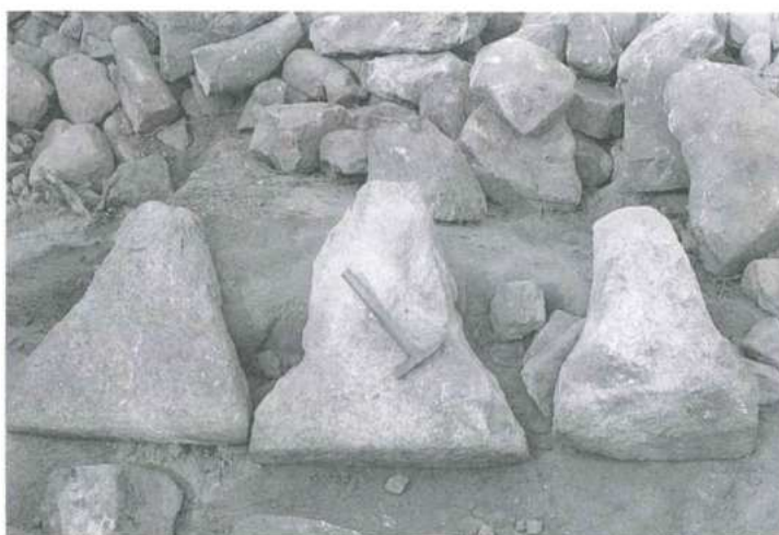
Fig. 18 — Fotografia mostrando a forma inteligente de trabalhar as pedras que vão formar as faces externas das muralhas. A pedra do meio, por exemplo, possui uma face rectangular com 20 cm de altura e 68 cm de largura. Na parte posterior elas são adelgaçadas, permitindo, assim, diminuir consideravelmente o seu peso e facilitando a sua colocação
