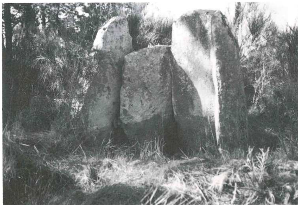
Fig. 6 — Aspecto geral da anta n.º 2, antes da sua demolição
