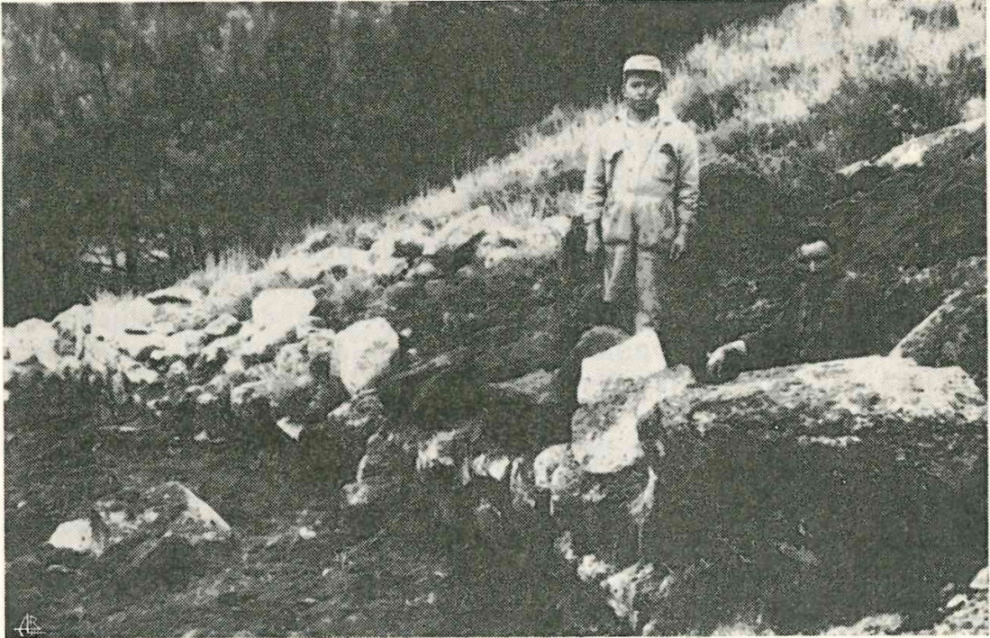
Fig. 1 — Muro da vertente leste do Castro de Carvalhelhos reduzido quase ao alicerce. O homem que se vê por trás do penedo onde o muro entesta indica o local preciso do achado da moeda e fibula
