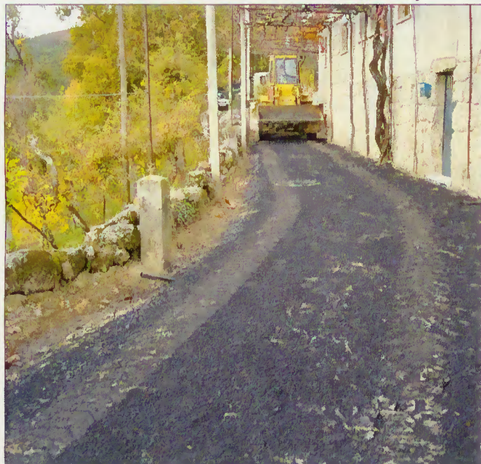
Pavimentação da via
