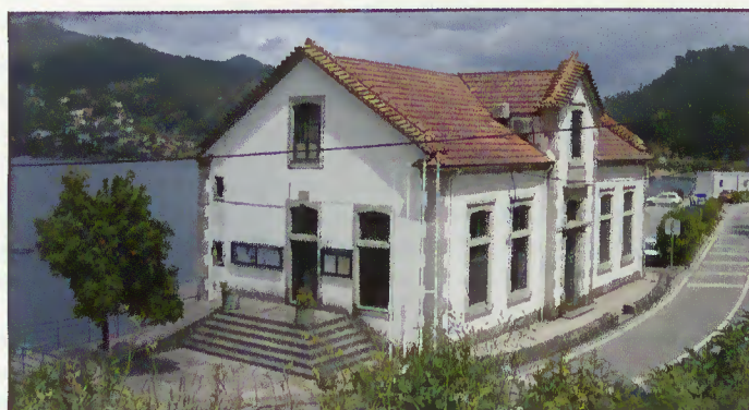
Extensão do Centro de Saúde de Rio Caldo
