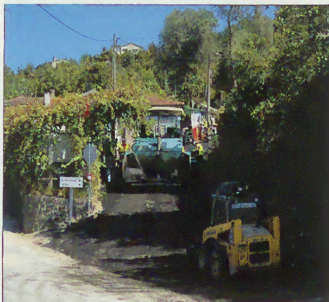
Execução de obras
