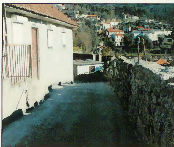
Construção da rede e pavimentação
