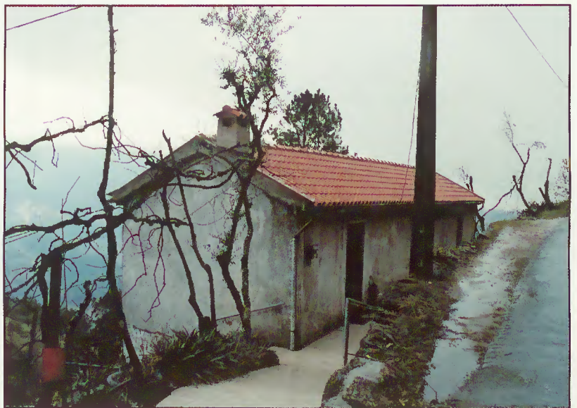
Substituição do telhado - Cibões
