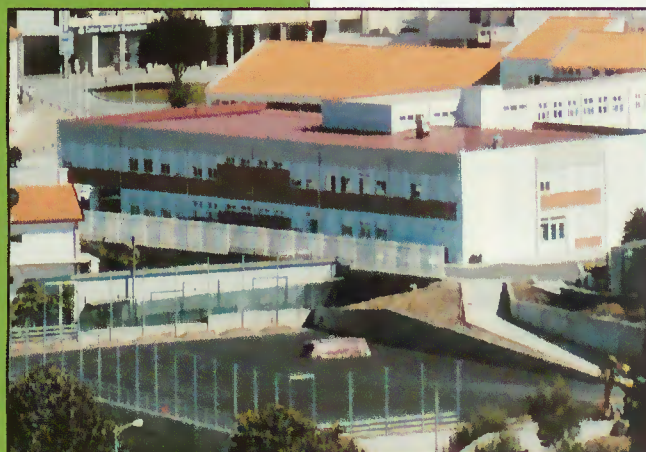
Vista panorâmica das Instalações
