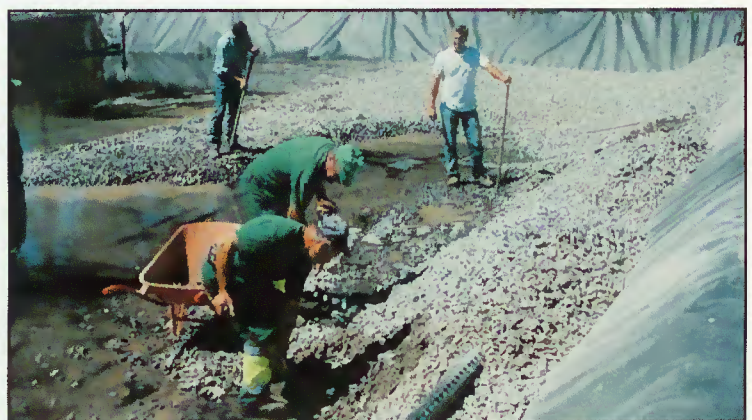
Constuição de ETAR rizosférica
