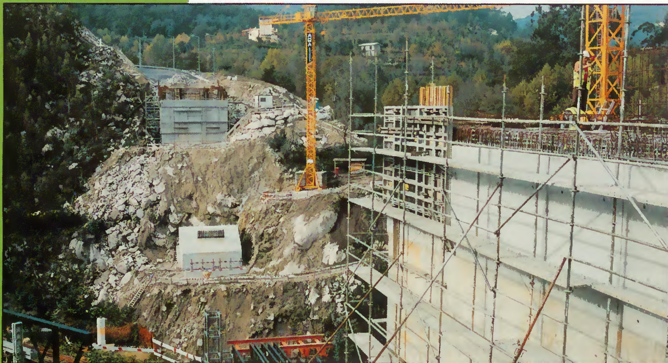
Uma das fases de construção
