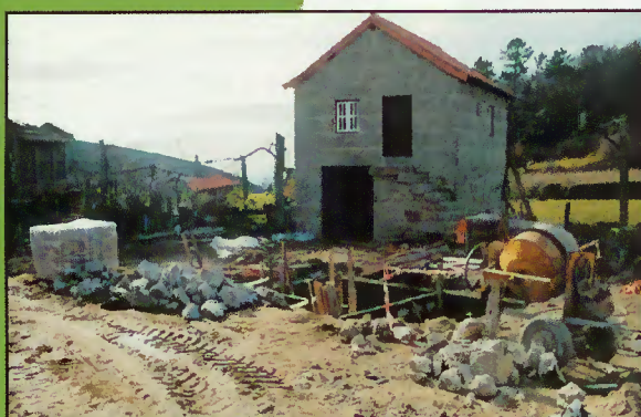
Construção de Saneamento básico em Rebordochão, St. a Isabel do Monte.
