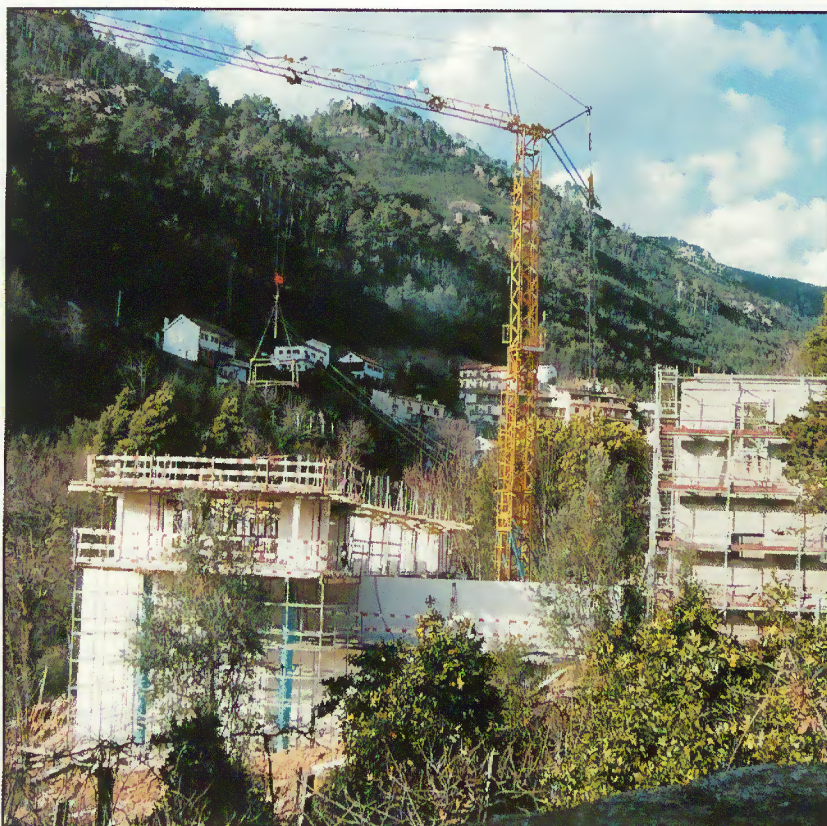
Obras em curso
