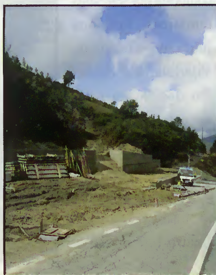
Execução de obras
