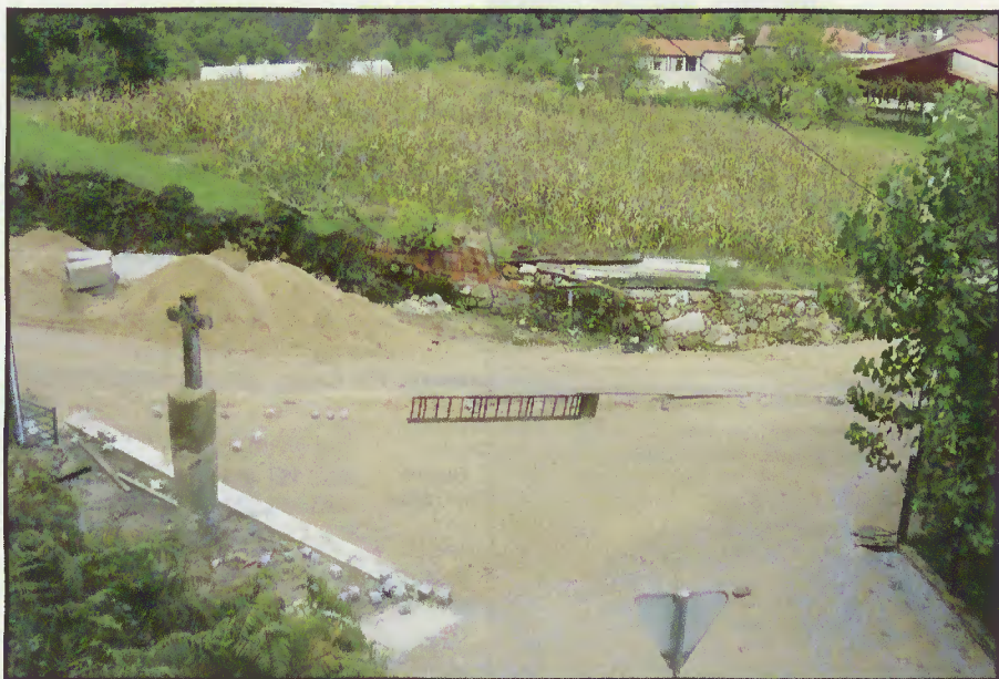
Execução de obras
