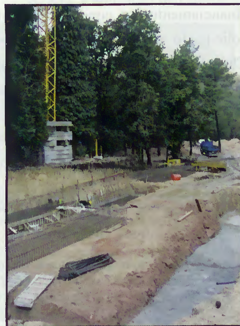
Fundações do edifício
