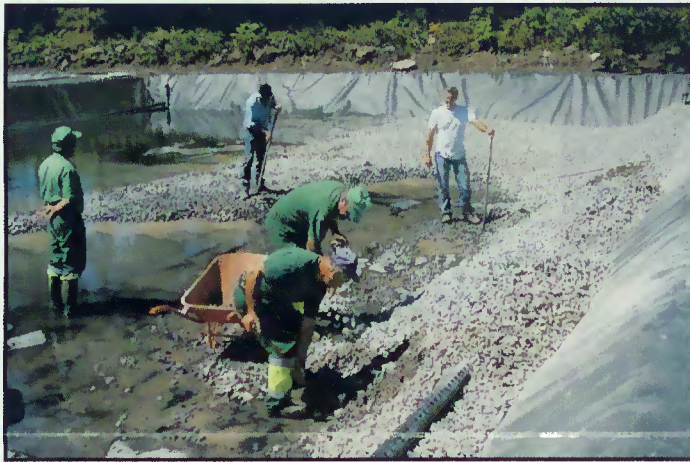
Construção da ETAR
