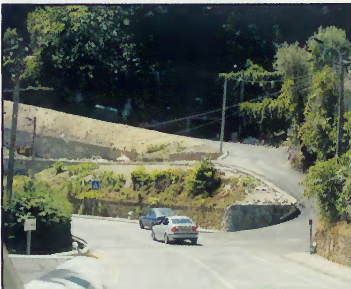
Acesso ao lugar de Paredes
