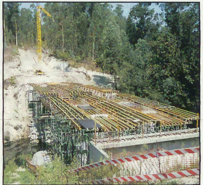
Obras em curso
