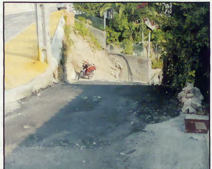
Pavimentação do arruamento
