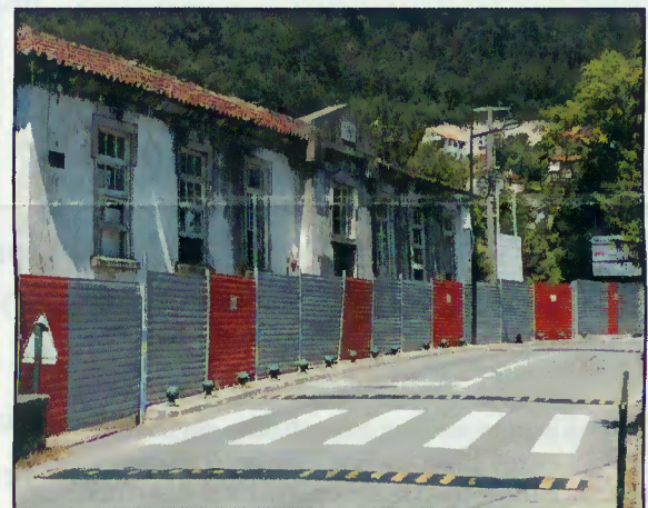
Início das obras
