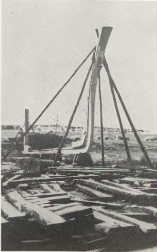
Estaleiros de Esposende: 1.ª fase da construção de uma embarcação
