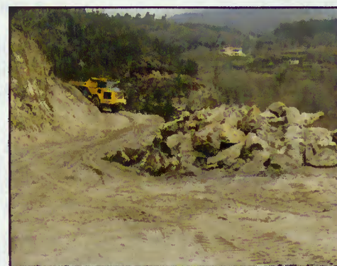
Obras em curso
