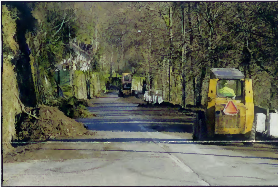
Limpeza da estrada entre Rio Caldo e Valdosende
