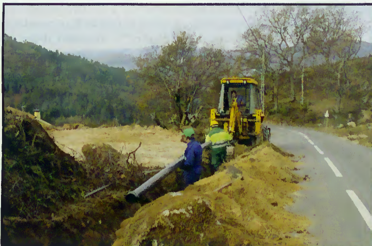
Execução do ramal
