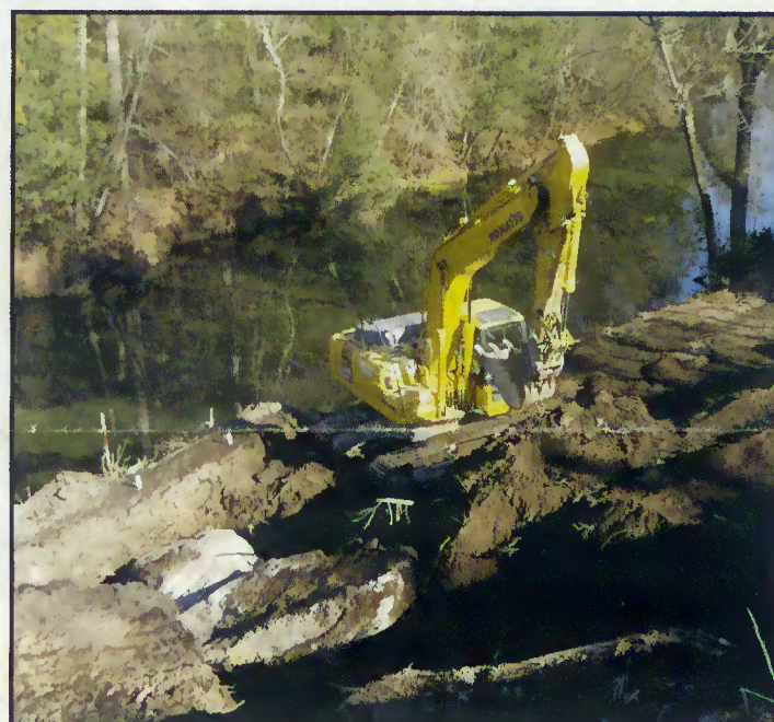
Construção dos alicerces da ponte
