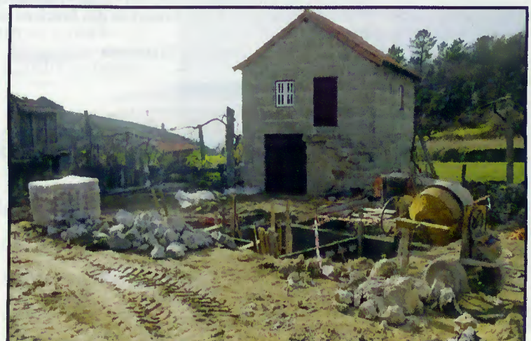
Construção da ETAR
