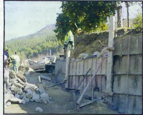
Execução das obras
