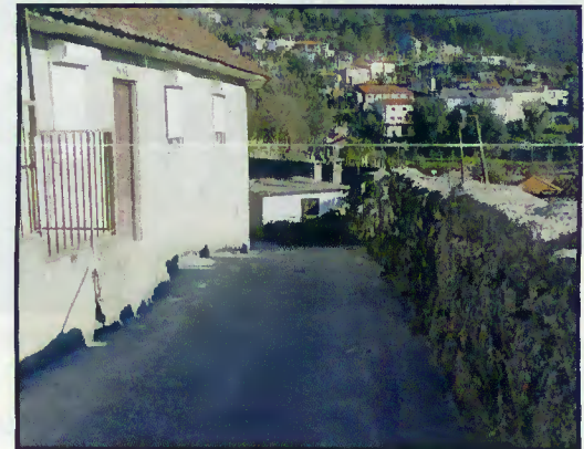
Pavimentação de caminho
