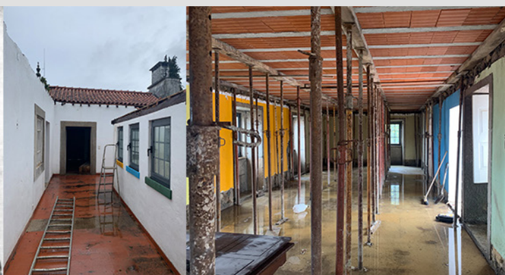
Interior da Residência Paroquial em obras (maio de 2024)
