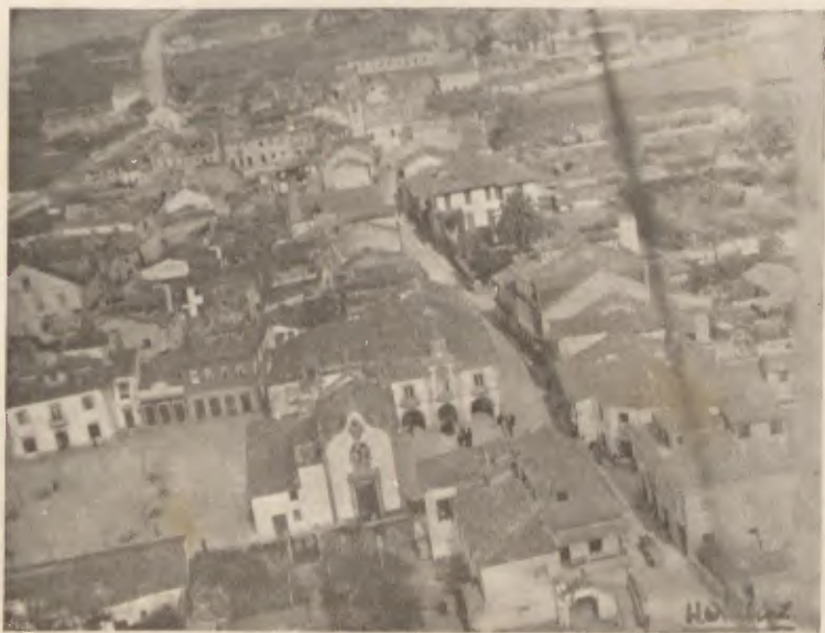
Vista aérea da Vila de Esposende
