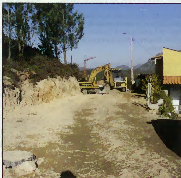
Abertura de arruamento e construção de redes de infra-estruturas
