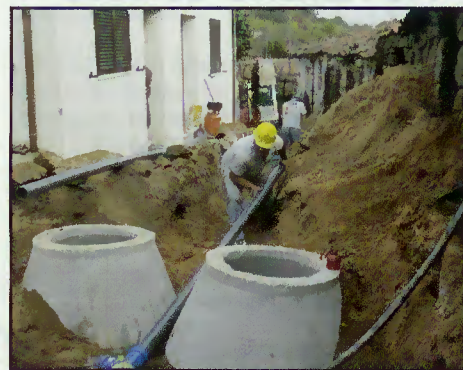
Execução das obras
