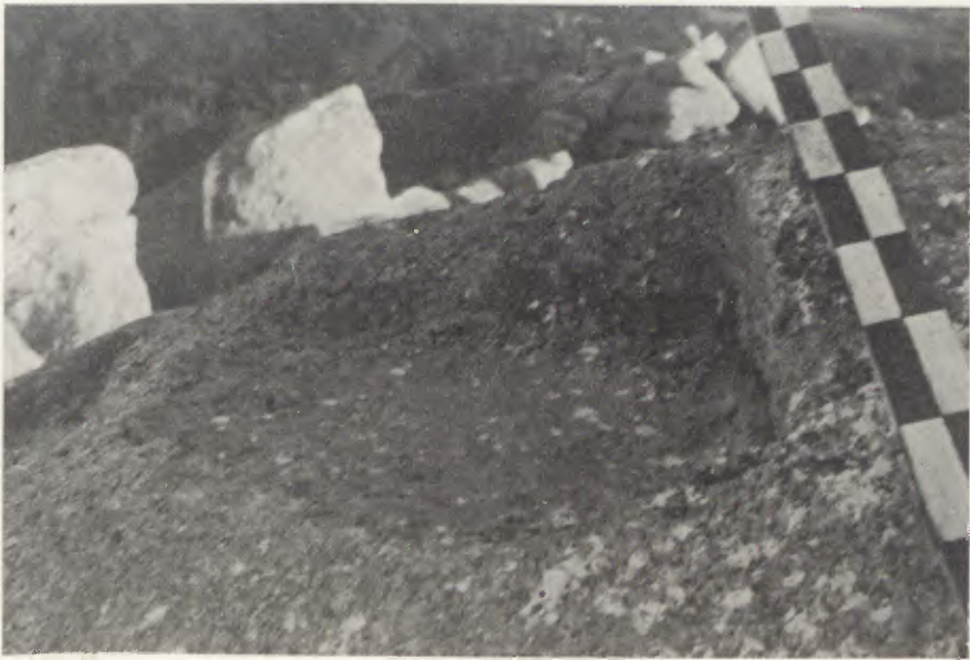
Fig. 4 — Corte para assentamento de muro da Torre
