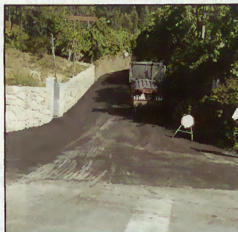
Pavimentação em Vau - Ribeira
