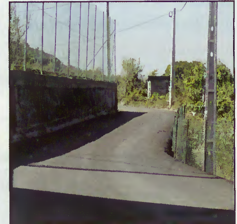
Pavimentação na Lagoa - Chamoim
