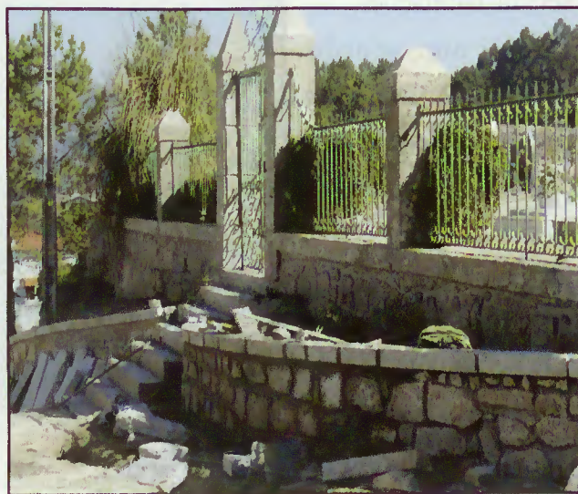
Ampliação do cemitério
