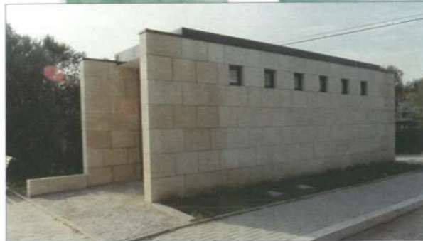
Sanitários públicos de Vila Chã
