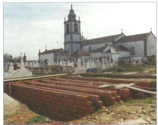
Ampliação do Cemitério de Fonte Boa
