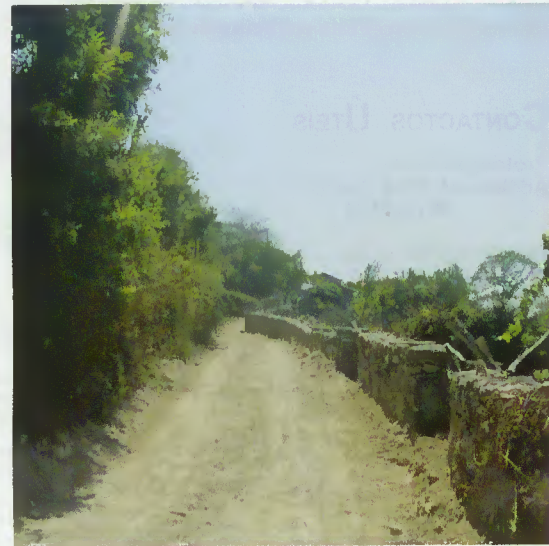
(Re)construção de muros
