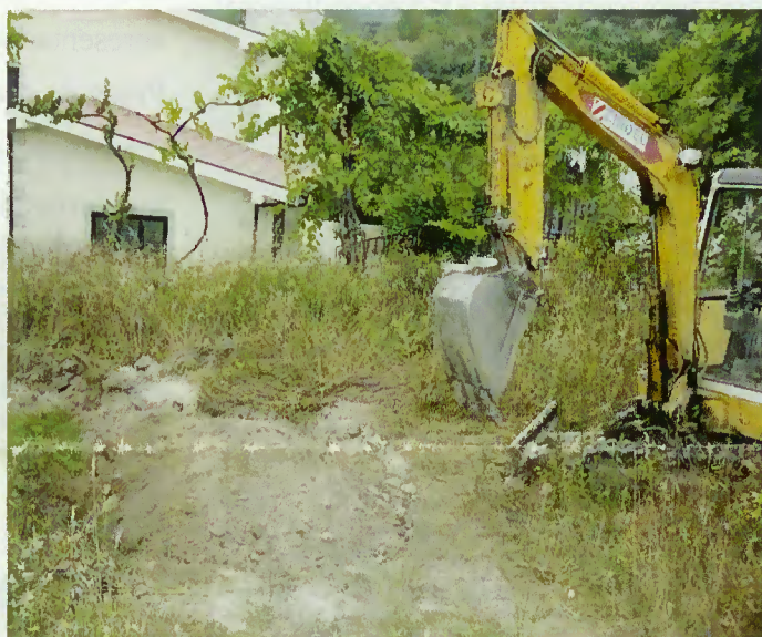
Execução da rede no Chamadouro
