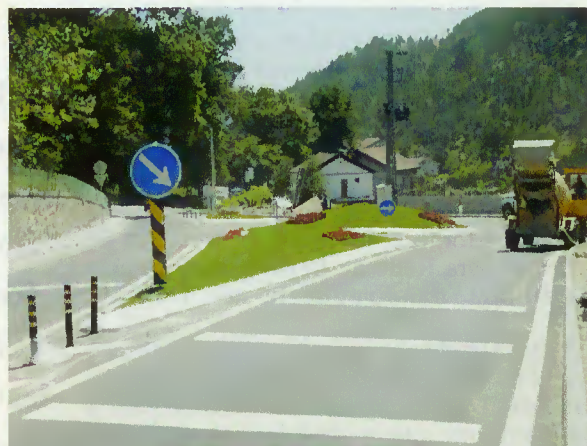
Colocação de sinalética
