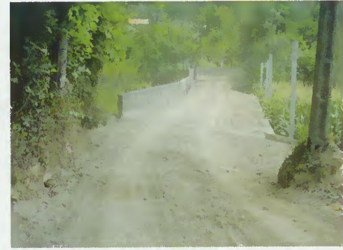
Intervenção nos acessos
