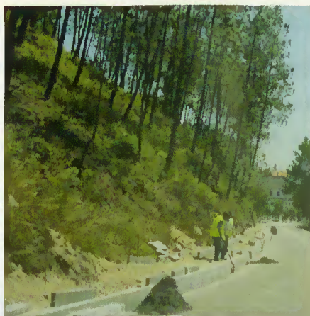
Construção de Passeio
