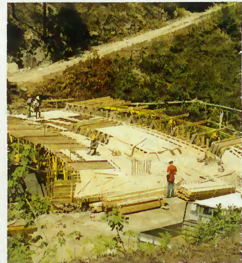
Ponte da Assureira em construção
