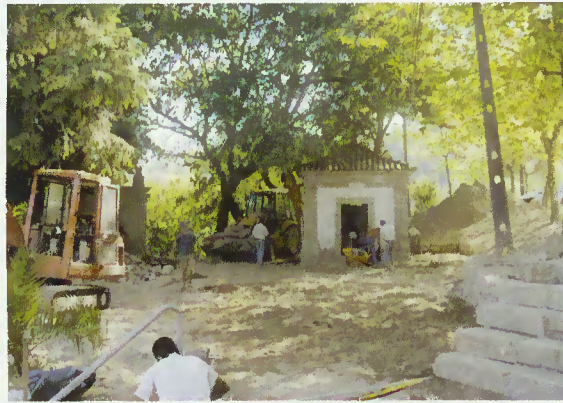
Obras de requalificação
