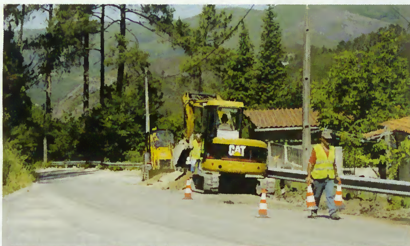
Construção da rede de água ao longo da estrada nacional
