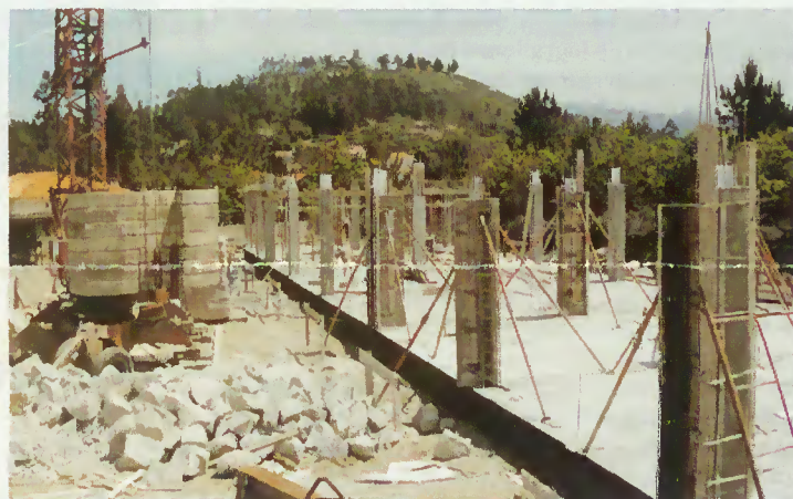
Obras em curso
