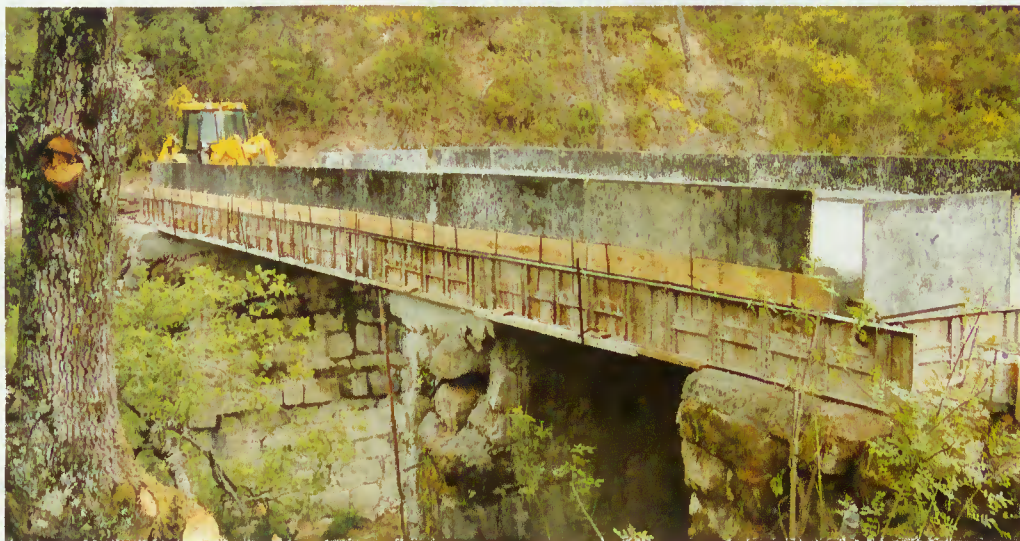
Execução do tabuleiro da ponte
