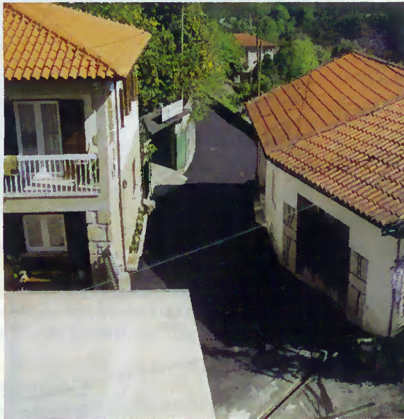
Pavimentação no lugar da Seara
