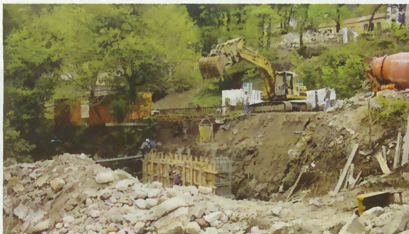
Construção do primeiro pilar da ponte
