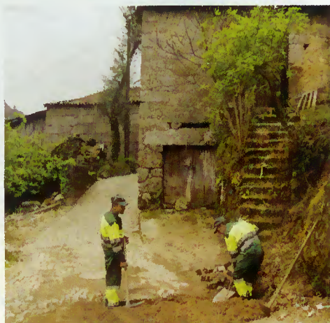
Funcionários executam remodelação da rede de abastecimento de água
