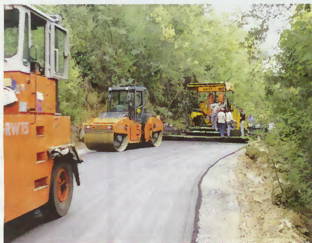
Trabalhos de pavimentação
