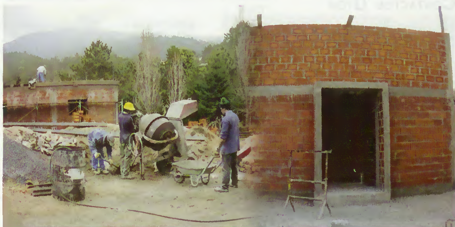
Execução das obras
