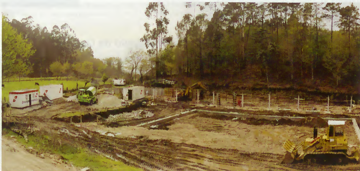
Construção dos alicerces de uma das partes das instalações
