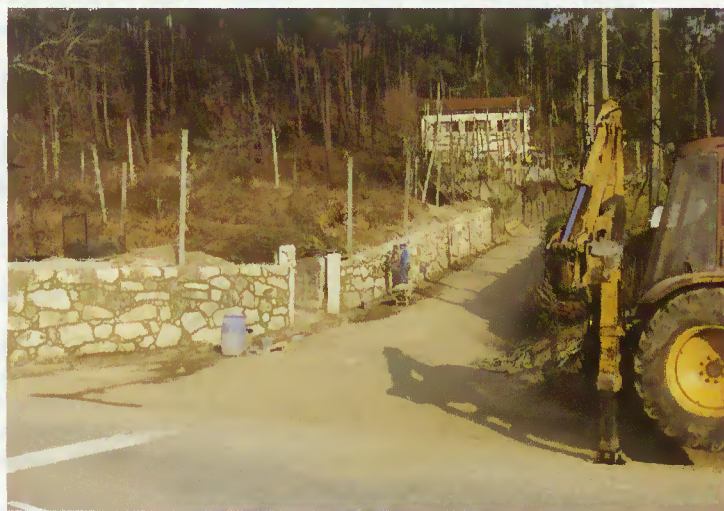
Visão parcial da intervenção
