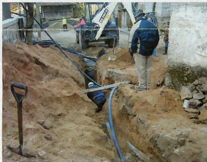
Execução das redes de água e saneamento em Sequeirós
