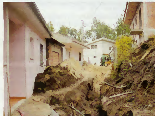
Rede em construção
