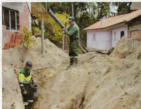
Funcionários executam os trabalhos
