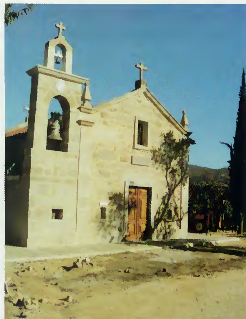
Intervenção no recinto exterior
