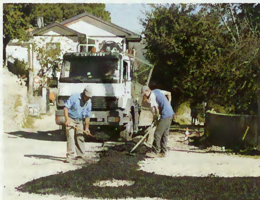
Pavimentação da zona intervencionada
