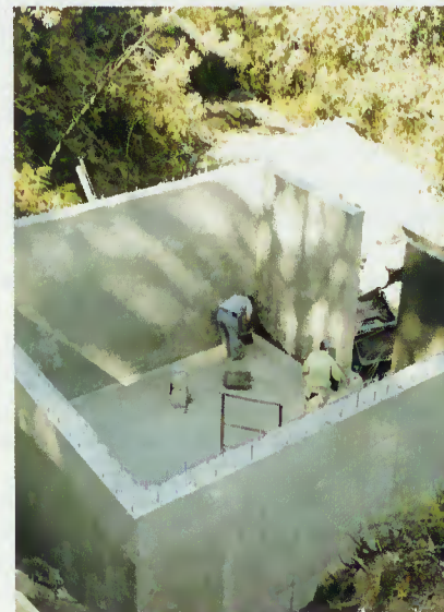
Execução das obras
