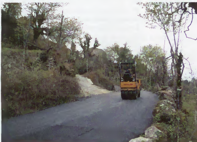
Obras no lugar de Bustelo - Gondoriz
