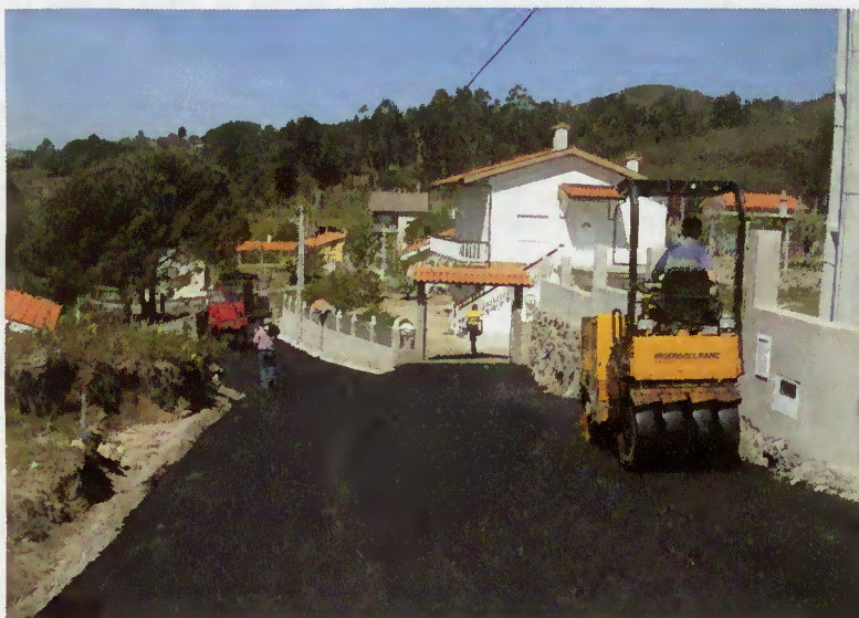
Obras realizadas no lugar Novo - Gondoriz
