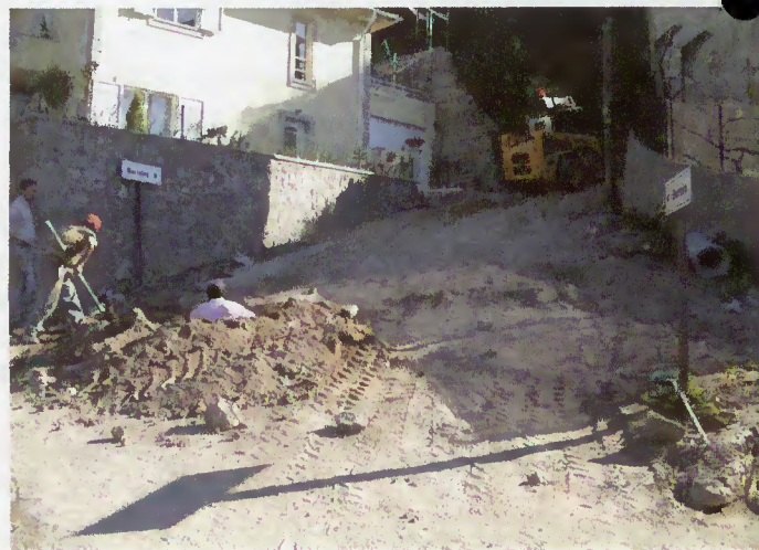
Obras no lugar do Barreiro - Moimenta
