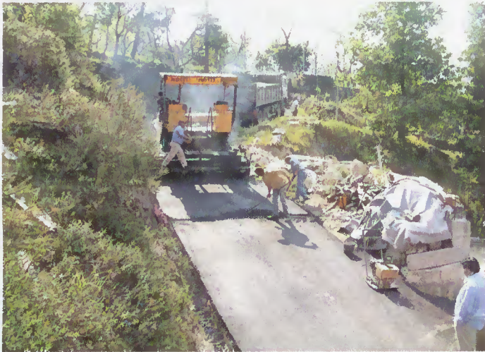
Obras no lugar de Admeus - Vilar da Veiga
