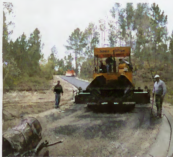
Execução das obras
