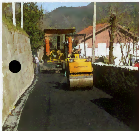
Execução das obras na Forcadeira
