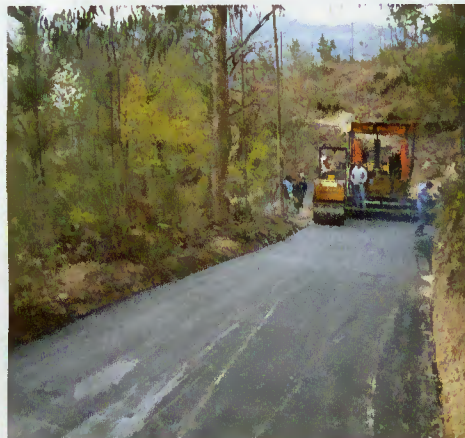
Execução das obras no Sudro
